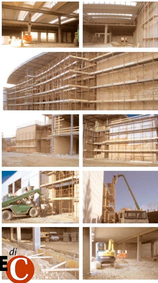
Il Cantiere – Foto di Silvano Roggero – www.edcspa.com
