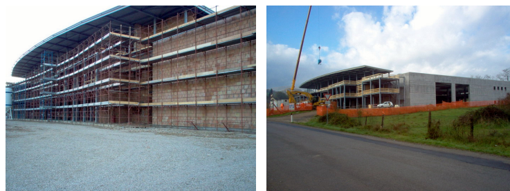
Lavori del Polo Lionello a gennaio 2006
