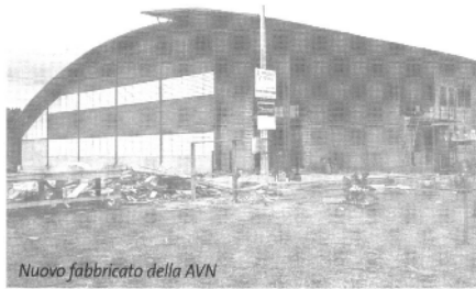
Nuovo fabbricato della AVN
